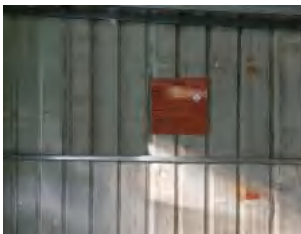
危废暂存间（内部）
