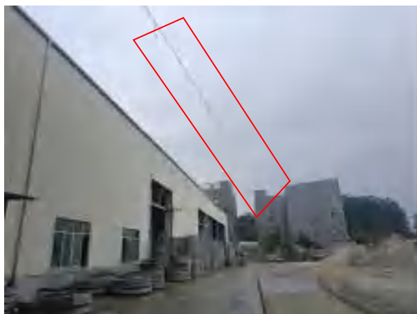
厂区道路设置喷淋装置
