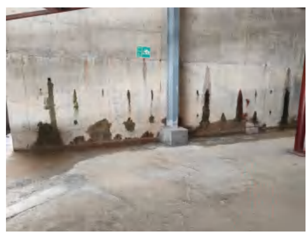
一般固废暂存场所（建筑垃圾杂物）
