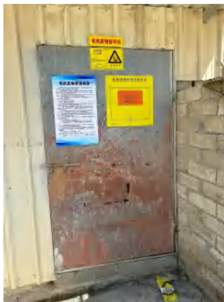
危废暂存间（外部）
