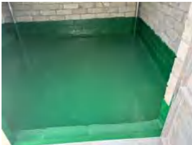
危废暂存间（内部）
