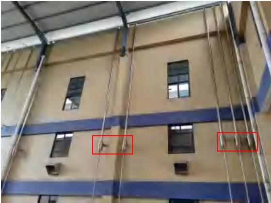
旋流分离器（24个），用于处理发酵废气
