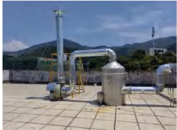
水洗净化，用于处理发酵废气，20m 排气筒（DA003）
