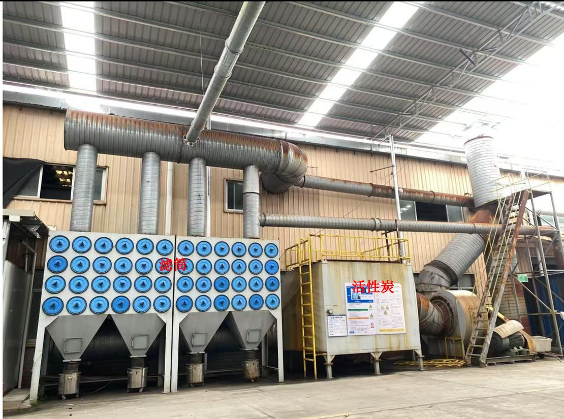
综合拆解废气处理设施：滤筒+活性炭吸附+15米排气筒（DA001）
