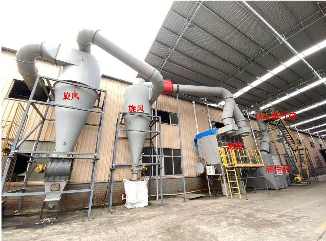
冰箱拆解线废气处理设施：两级旋风+滤筒+活性炭吸附+15米排气筒（DA002）
