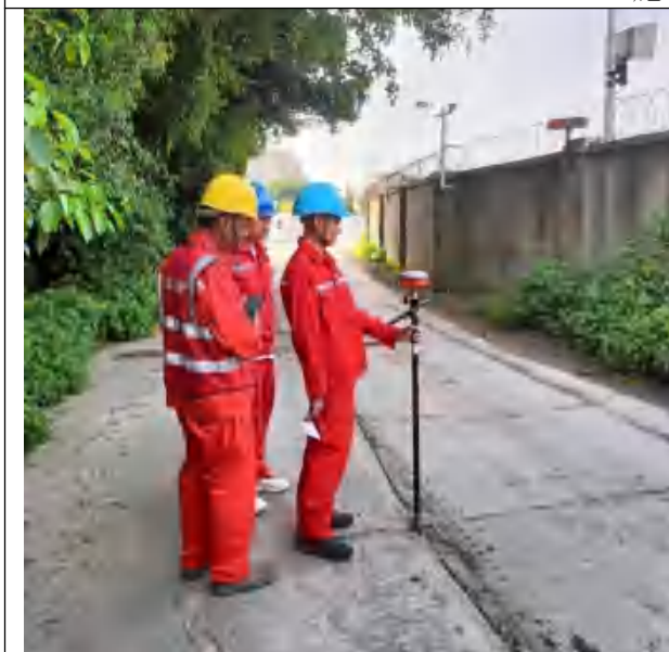
基准点、围墙基础位置核对，严格控制施工区域
