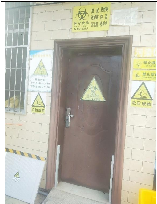
医疗废物暂存间
