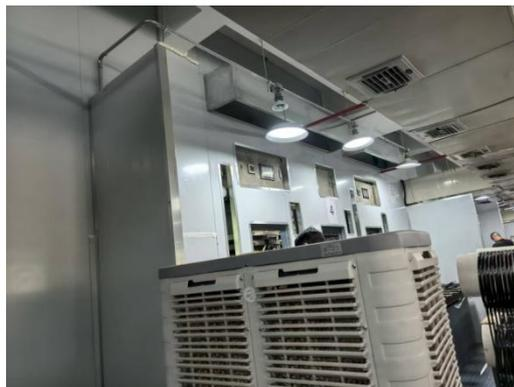
热压成型废气集气收集
