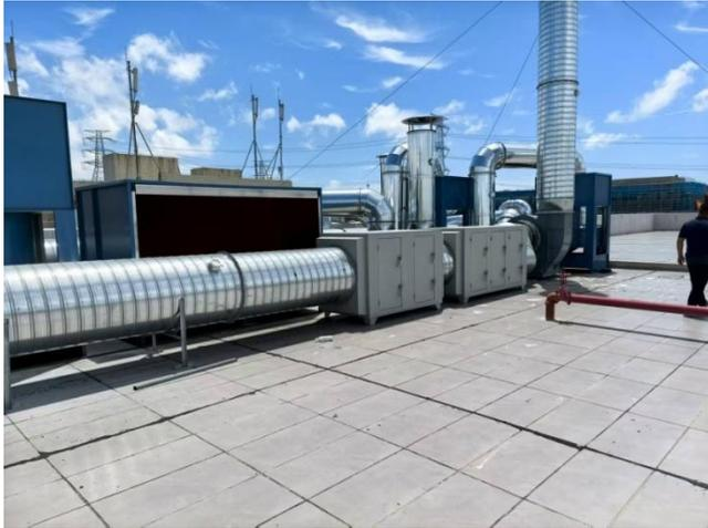
(Q1 排气筒) 气旋喷淋+二级活性炭吸附设施、(Q3 排气筒)
