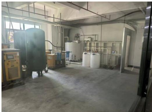
5t/d 混凝反应+沉淀+过滤”工艺污水设施
