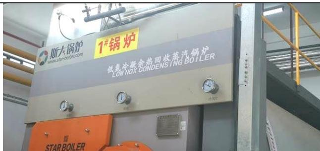
低氮冷凝余热回收蒸汽锅炉
