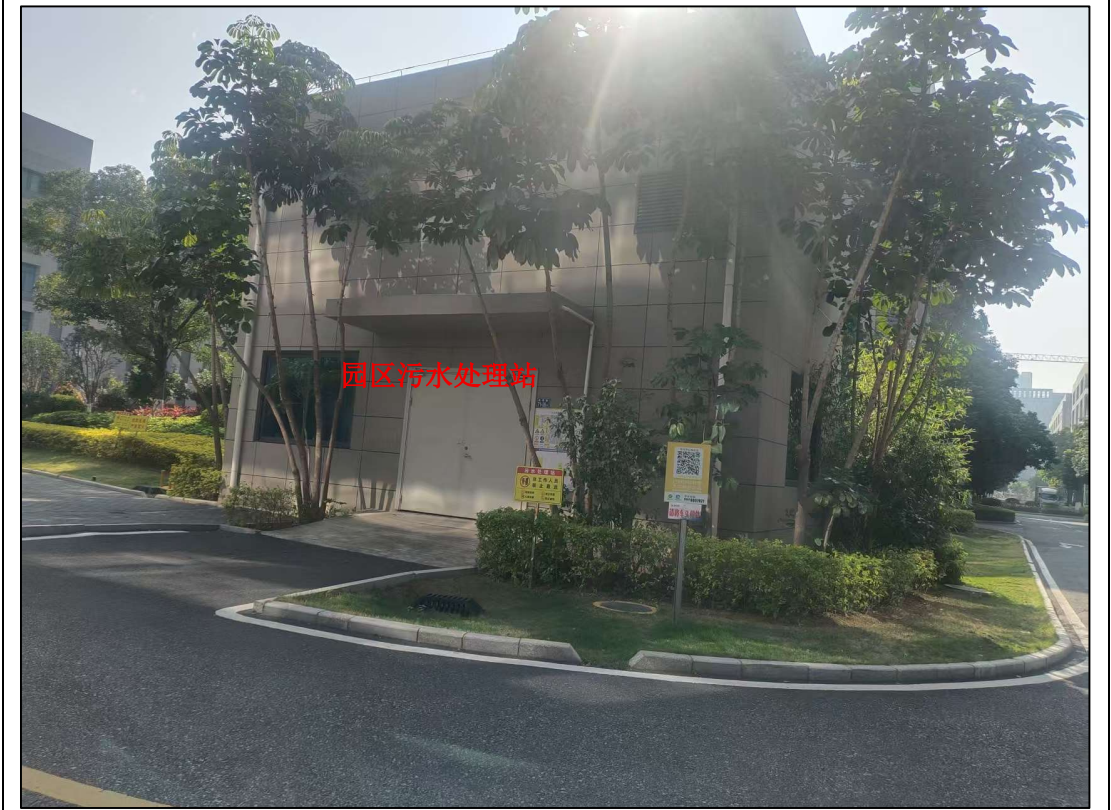
图 3-1 园区污水处理站现场照片
