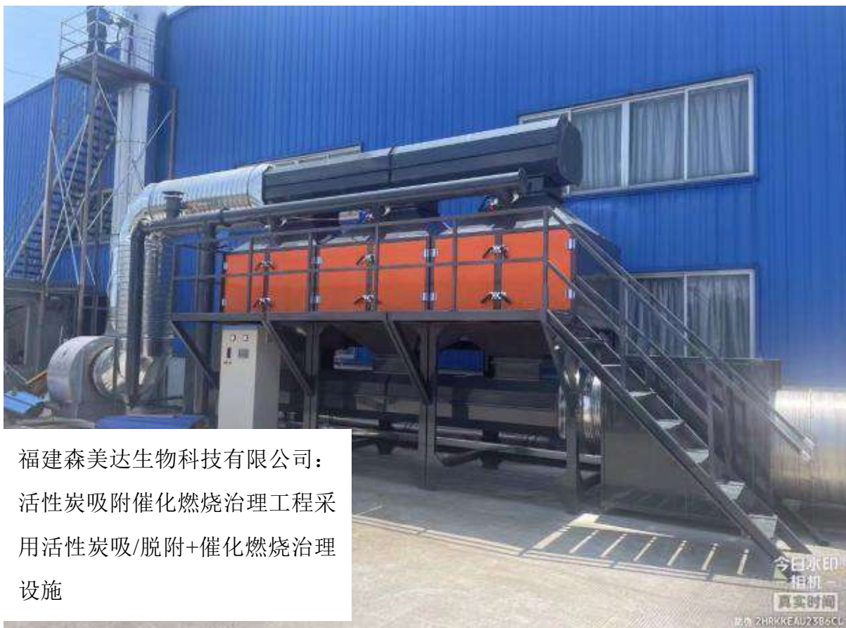
图 5.2-2 森美达废气治理提升改造工程现场照片
