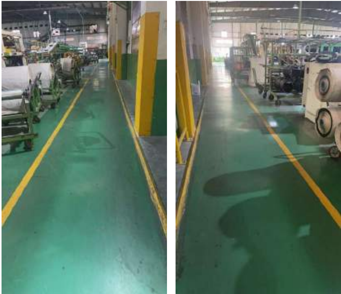
图 5.3-4 厂区硬化地面
