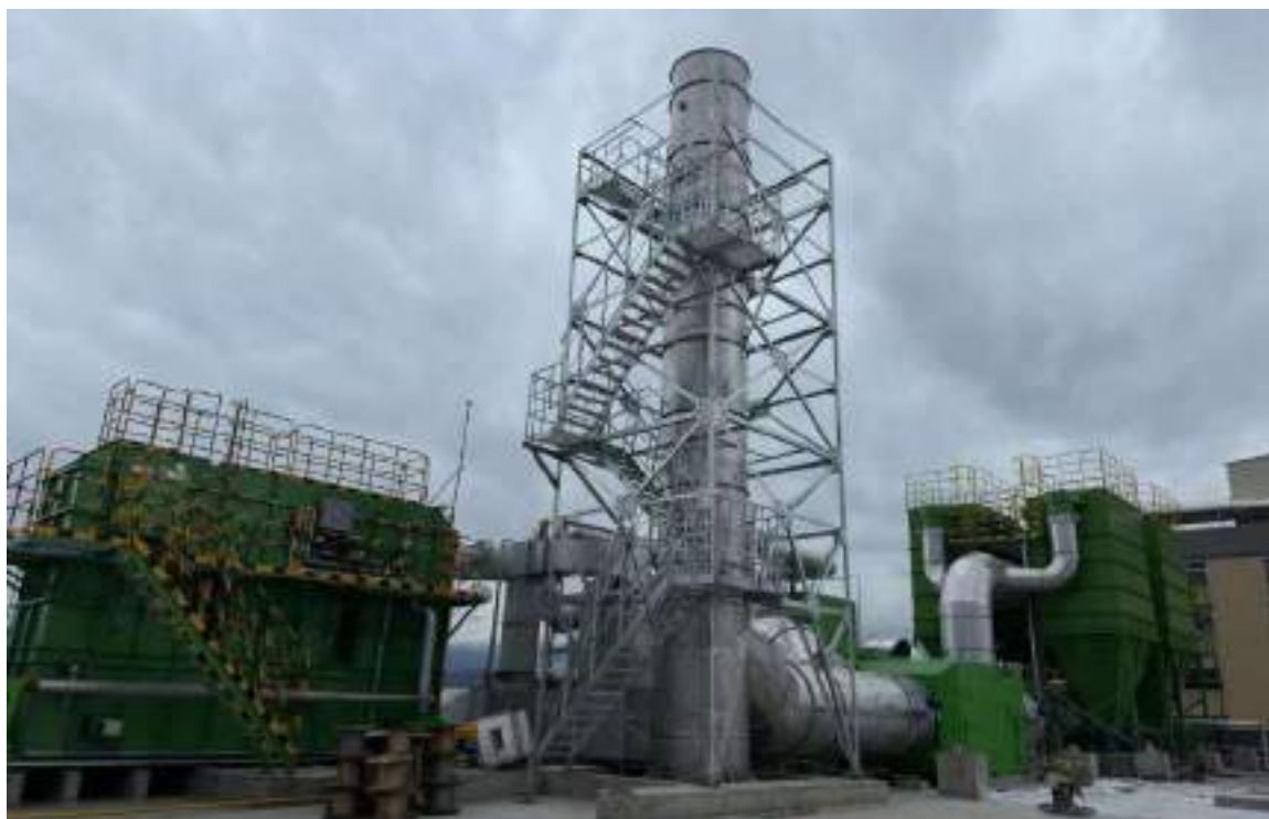
图 5.2-3 建新轮胎废气治理提升改造工程现场照片
