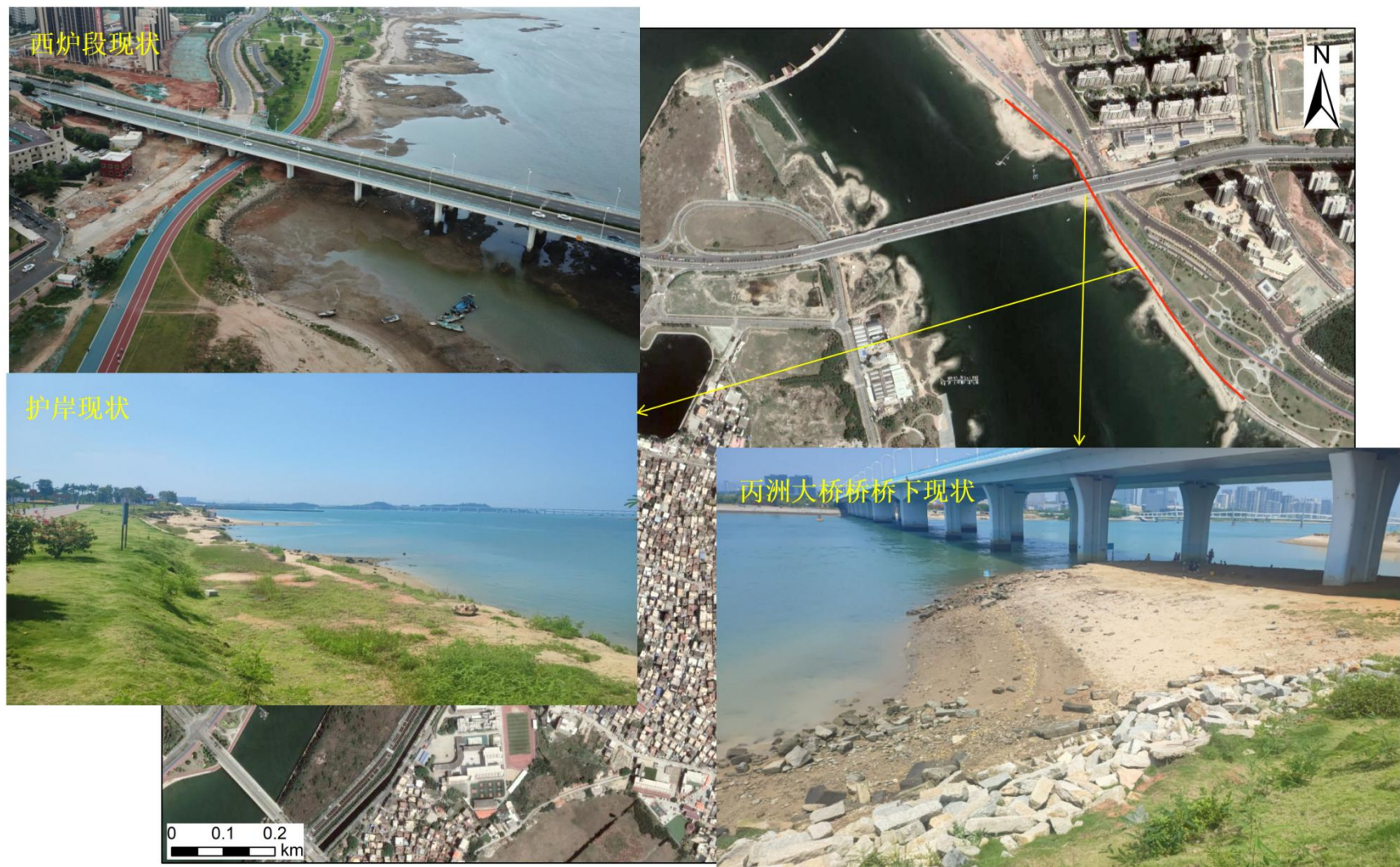
图 3.1-3 西炉段现状情况
