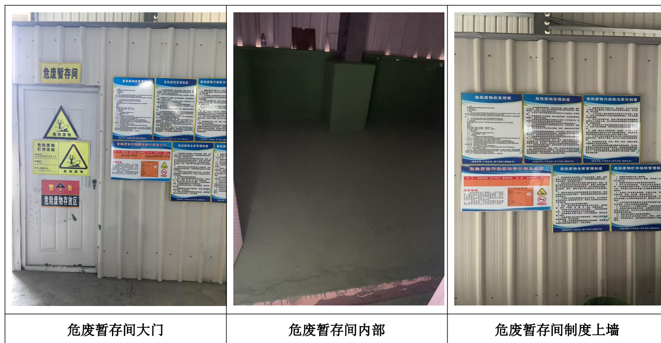
图 4.1-4 项目固体废物设施现状图
