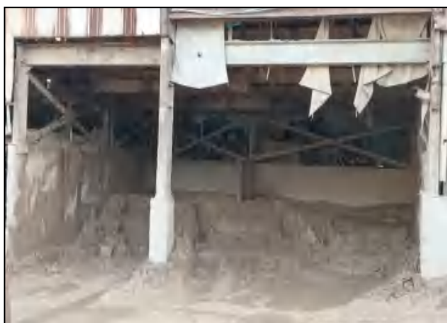
图 4.1-5 一般工业固体废物暂存区
