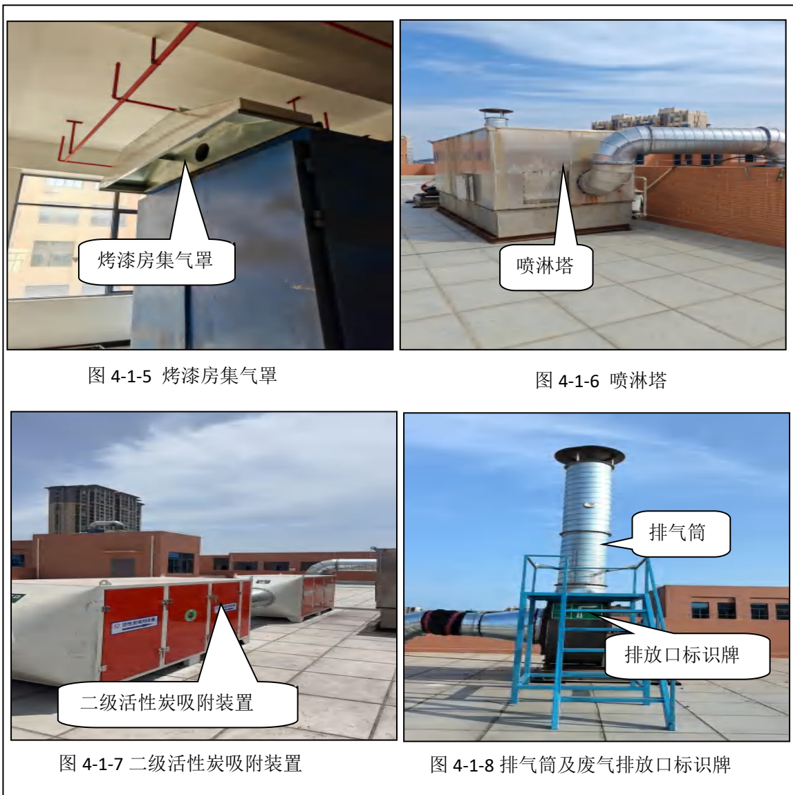
图 4.1-6 调/喷烤漆废气处理设施图
