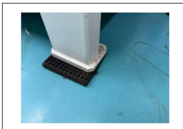
图 4.1-3 设备底座减振
