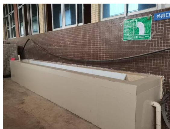
生产废水明渠排放口
