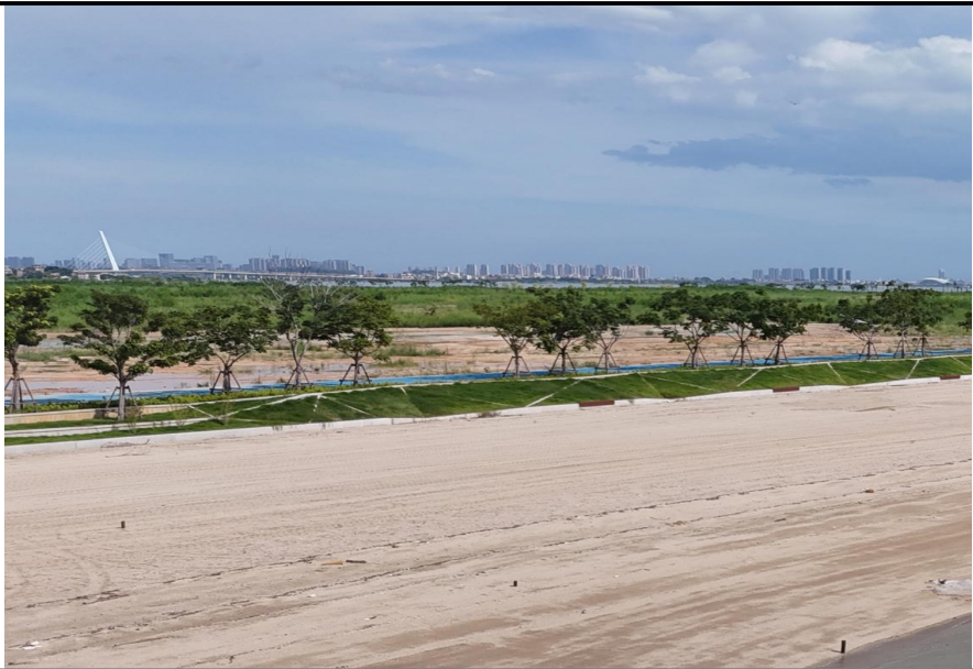
绿化工程恢复现状
