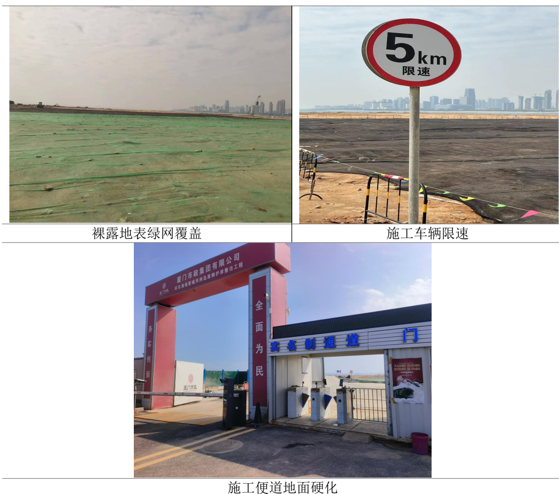
图 4.2-1 施工期大气污染防治措施照片
