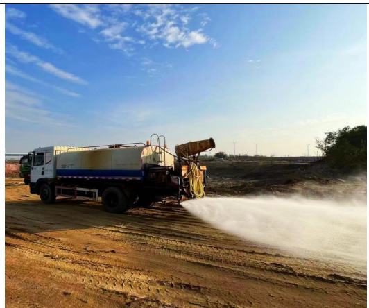
施工场地洒水车洒水降尘
