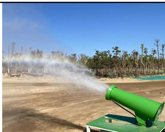
雾炮机喷淋降尘
