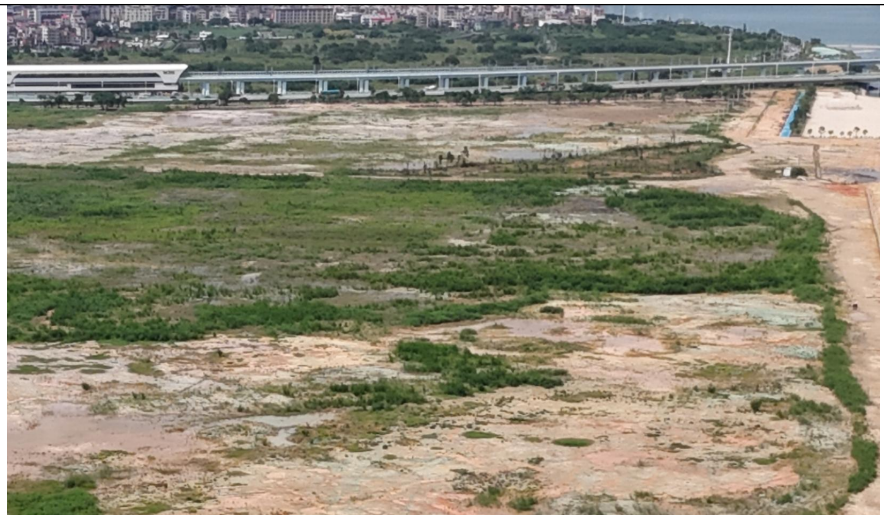
施工场地临时用地植草恢复现状
