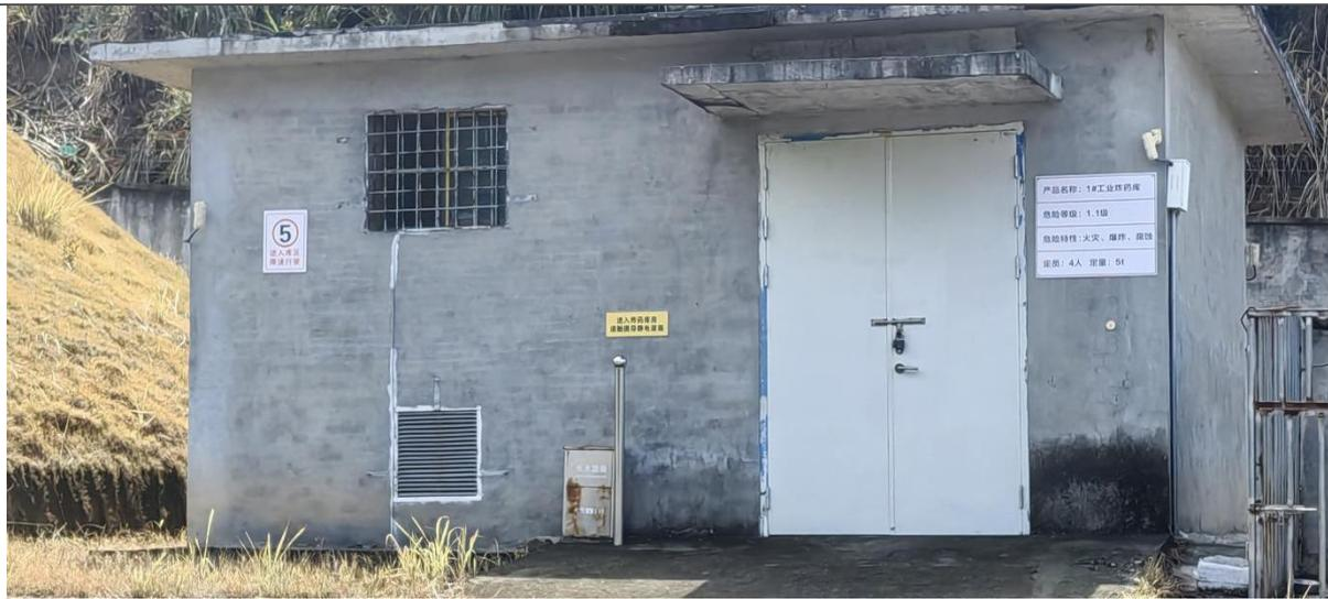
仓库门口张贴标识牌，并配置静电装置、灭火器、周界报警装置和库房入侵报警系统等
