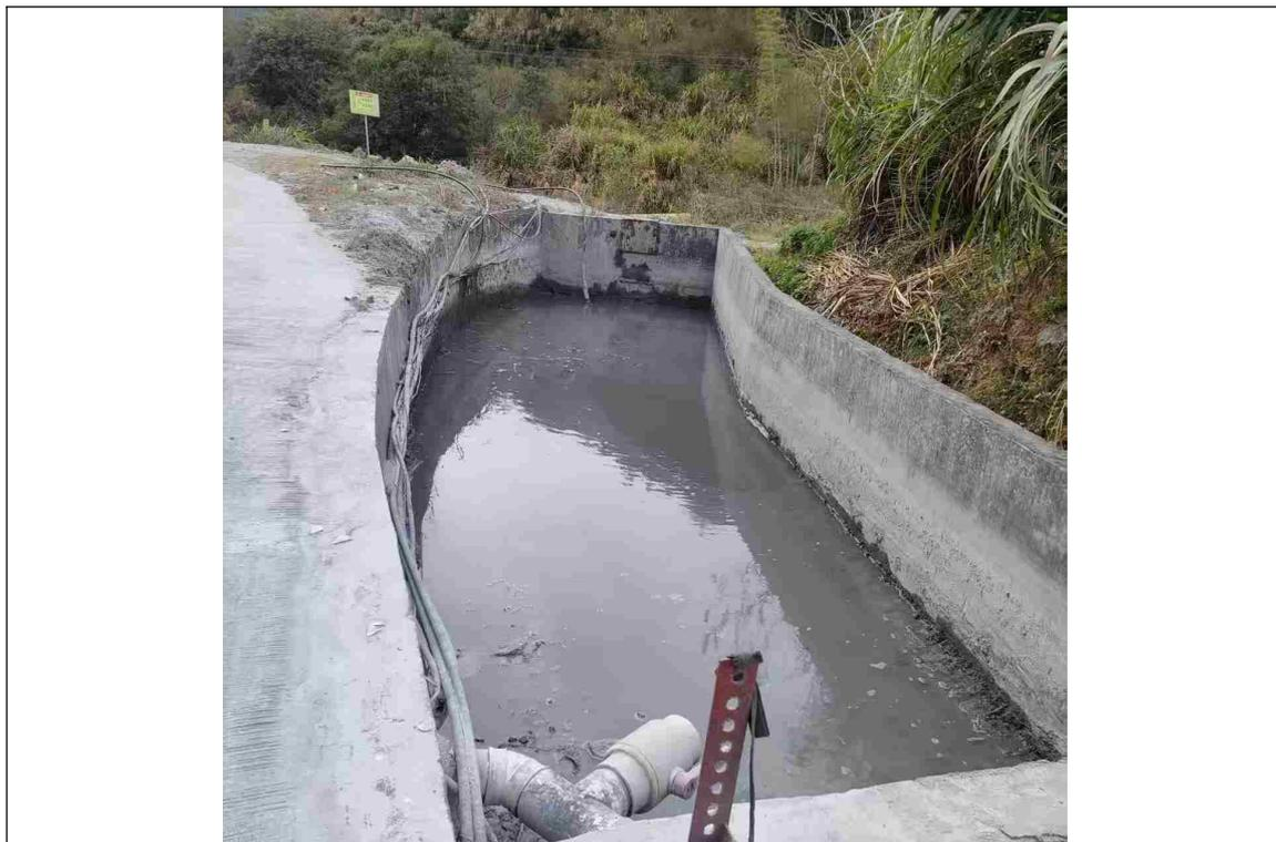
项目现有工程——初期雨水收集池（长 20 米宽 4 米深 2 米）
