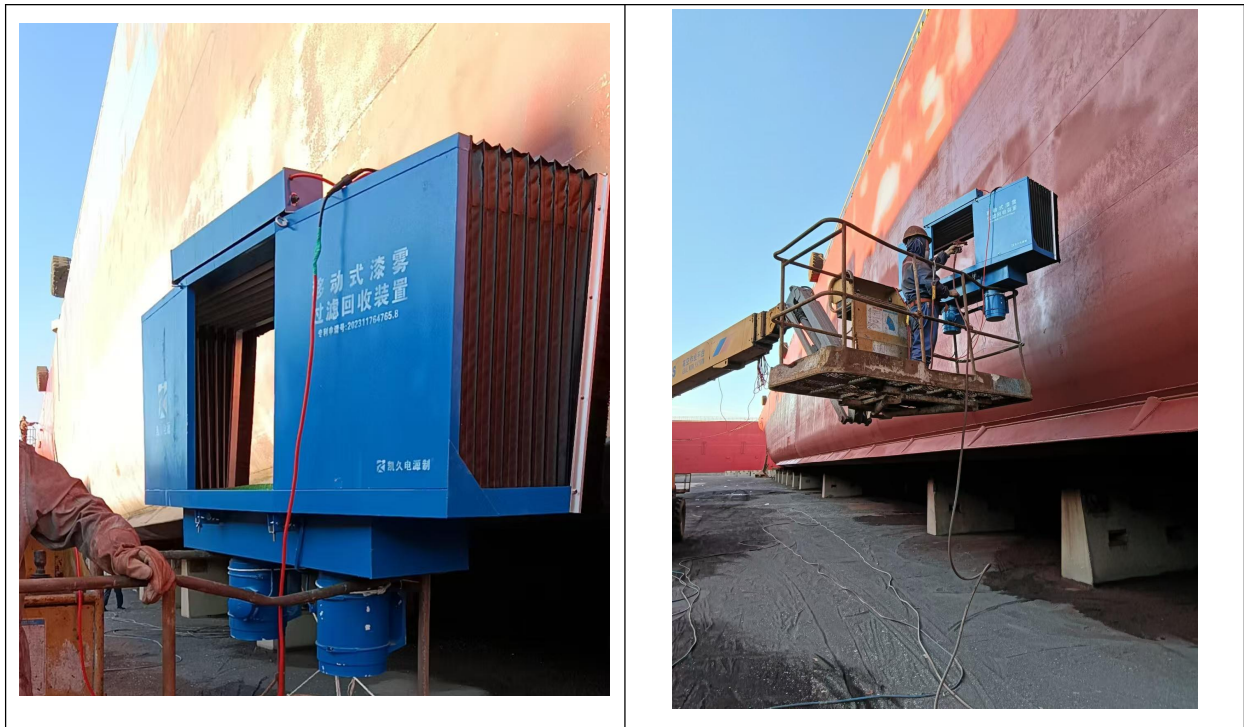
图 4-2 废气治理设施
