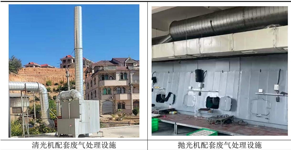
图 4-4 项目废气处理设施图
