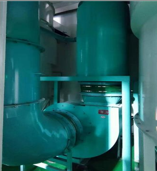
碾米工段 P5 排气筒废气处理设施
