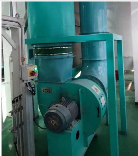
抛光色选工段 P3 排气筒废气处理设施
