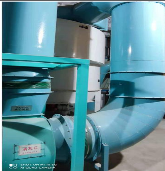
原料接收预处理 P13 排气筒废气处理设施
