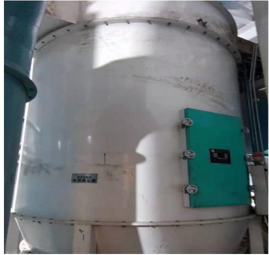
原料接收预处理 P12 排气筒废气处理设施
