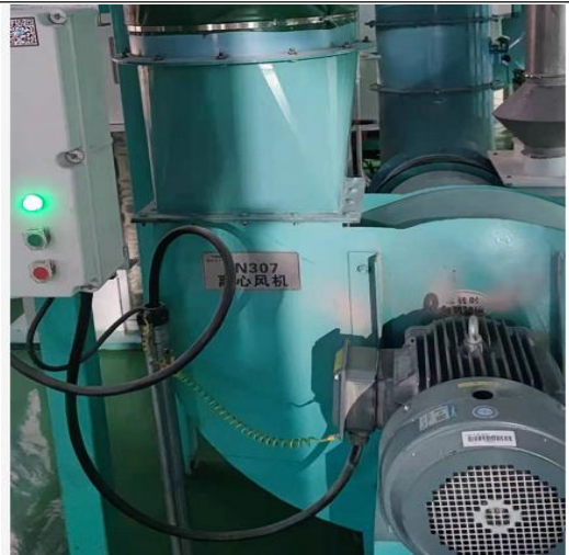
碾米工段 P6 排气筒废气处理设施
