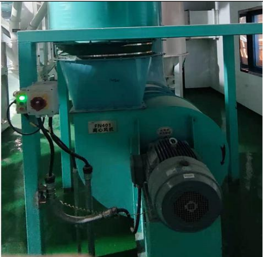
碾米工段 P7 排气筒废气处理设施
