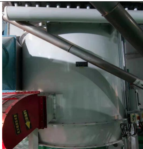
抛光色选工段 P2 排气筒废气处理设施
