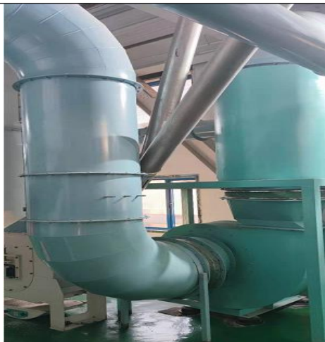
抛光色选工段 P2 排气筒废气处理设施
