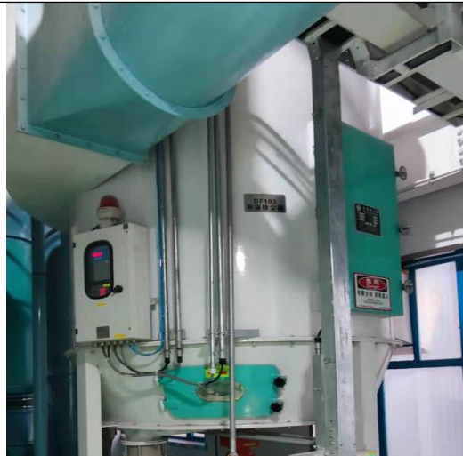
清理砬谷段 P9 排气筒废气处理设施
