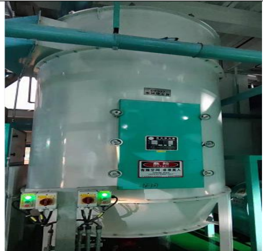
碾米工段 P6 排气筒废气处理设施
