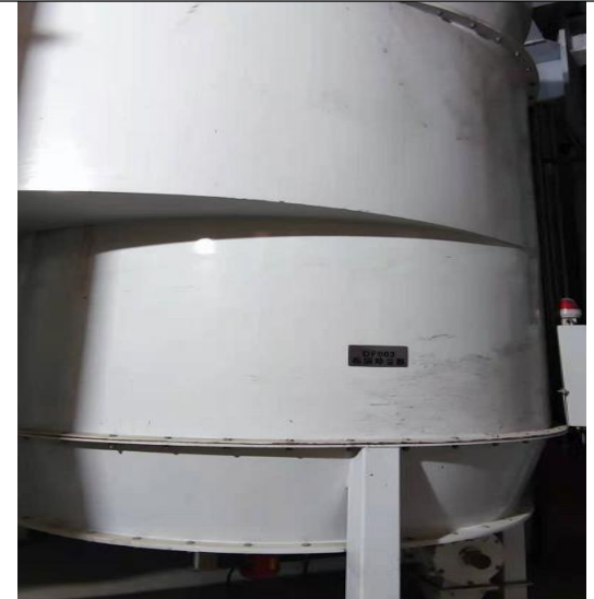
原料接收预处理 P13 排气筒废气处理设施
